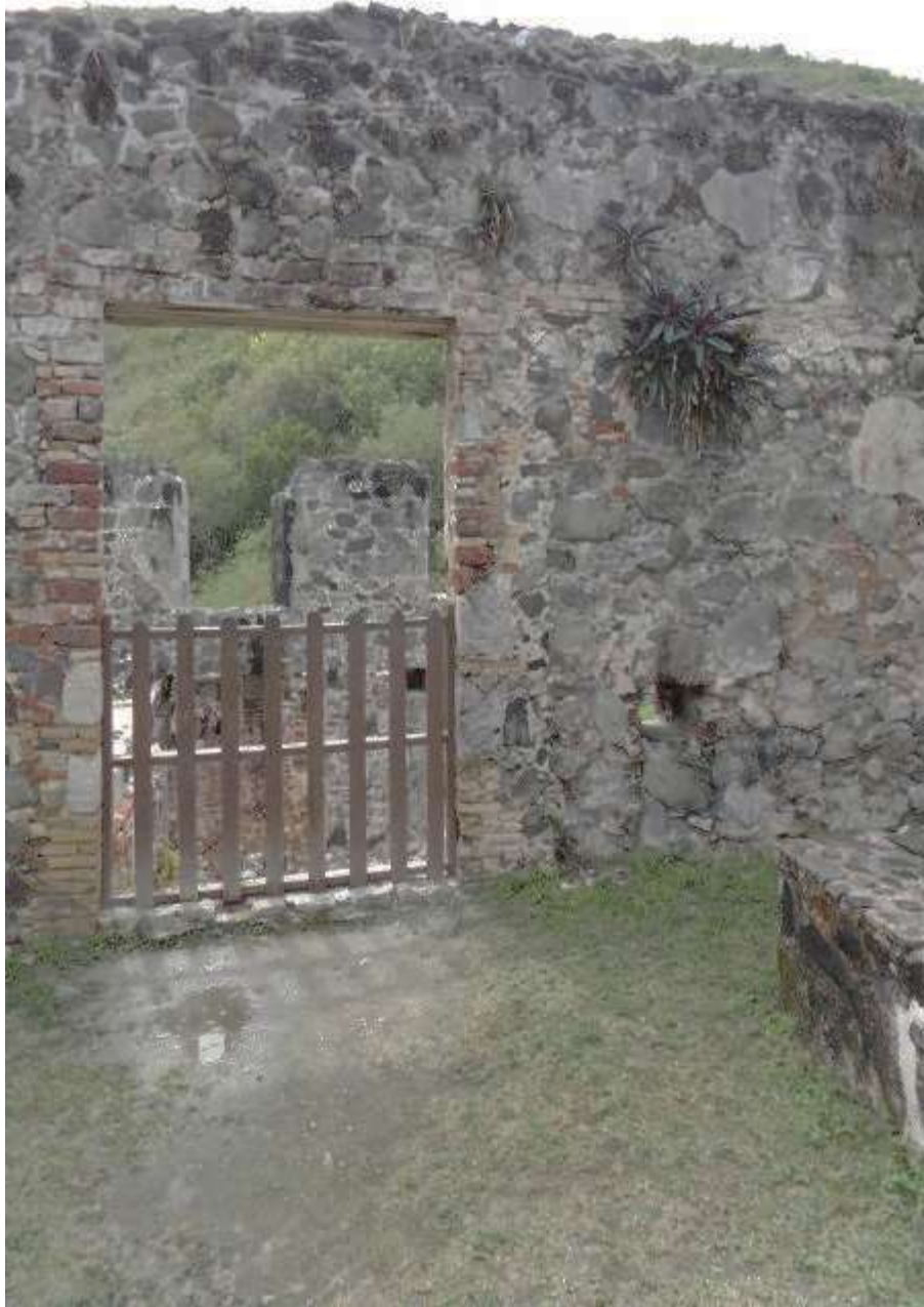
Figur 11 Sct. John Annaberg plantage bygning, bygningen består af mange slags sten. De fleste er vulkanske basalt og tufsten (grå), indimellem findes koralkalk blokke (hvide) og omkring dørene og vinduerne røde mursten. Murstenene er importerede fra Danmark. Sejlskibene sejlede i ballast til øerne. Ballasten var for det meste mursten fra Flensborg området. Stenene blev solgt og lasten fyldt med sukker, melasse og rom før afrejsen til Danmark.
