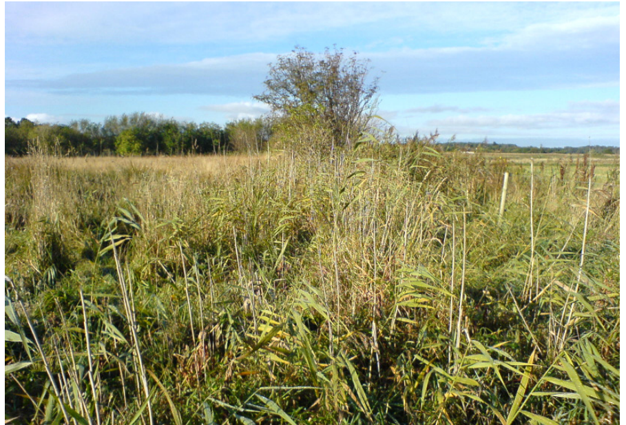
Del af dige beliggende på lokalplanområdet.
