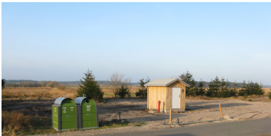
Vandværksgrunden med bygning, der bibeholdes. Bygningen indeholder vandmåler mv.
