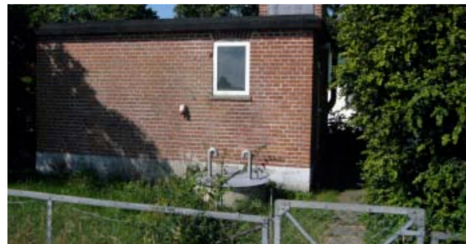
Onsevig Vandværk har en skovboring med en fin vandkvalitet. Anlægget kræver investeringer for at være fremtidssikret
