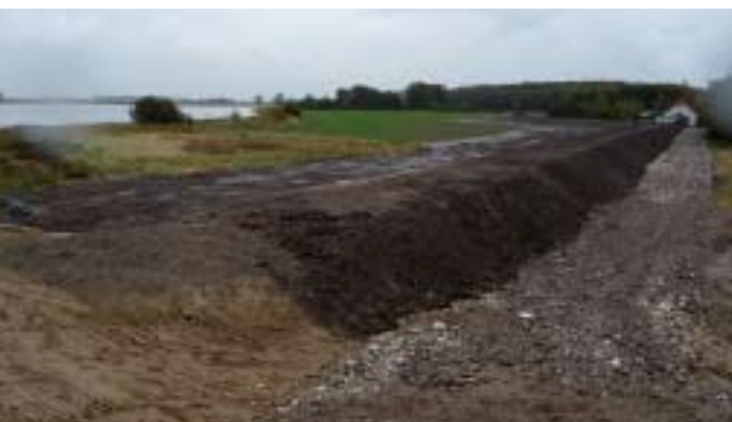
Entreprenørarbejde i efteråret 2008 med etablering af Østdiget.
