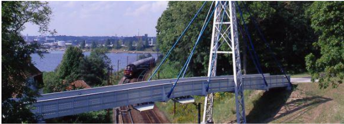
Figur 46 Fiberline-broen ved Kolding
