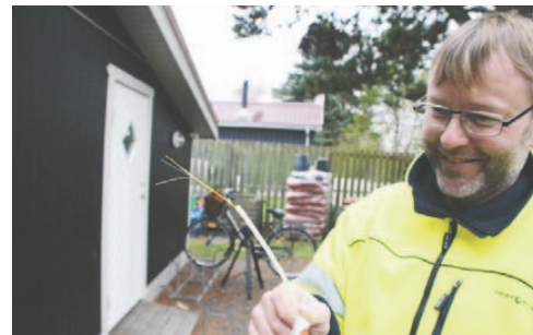
Torben Jensen havde fat i den lange endnu udenfor, hvor fibernet-kablet på 250 my i diameter, ventede på at blive trukket ind i varmen.
