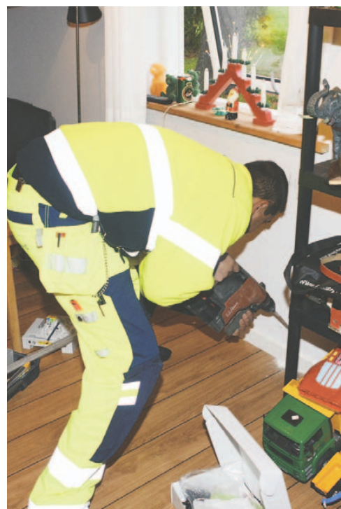
Inde hos Inger-Lise stod Ateeq Shakar klar til at bore gennem muren, så kablet kunne trækkes, og den moderne tidsalder kunne rykke ind på Askø Strandvig 237.
