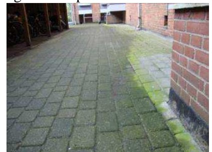
Belægninger er generelt i god stand. Belægninger bør holdes frie for alger.
