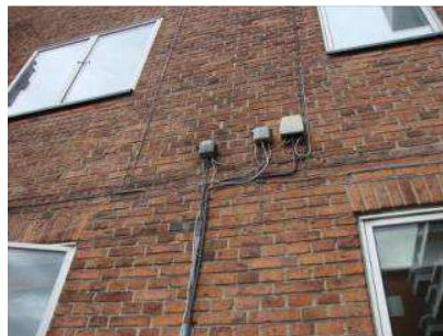
Gamle installationer på facader, som ikke længere er i brug, bør fjernes (er med i afsnit 03)
