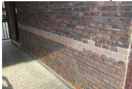
I portpassagen, er der udskiftet mursten, som tidligere var ødelagt at containere.
