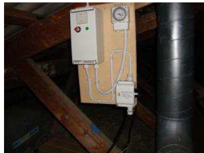
Automatik for udsugning fra Palermovej 19.
