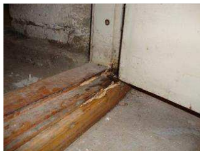
Svampeangreb som forrige foto. I 2016 er svampen ikke så slem som i 2011, men dette dørtrin anbefales lavet, så det bliver støbt i stedet for et trædørtrin.
