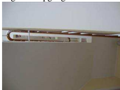
Der er smal passage op gennem ejendommen mellem trappeløbene.
