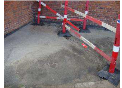
Der er en igangværende opgravning mod Strandlodsvej (2011).
