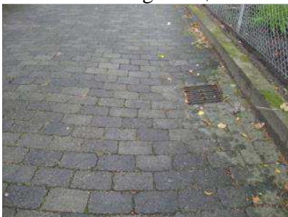
Belægninger er generelt pæne, jævne, hvorfor det formodes, at kloakker ikke er utætte. Foto er fra 2011.
