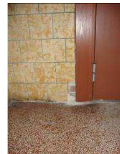
Enkelte klinker mangler, men generelt er klinkerne på væggen i god stand.
