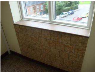
Brystning under vinduer med klinkerbeklædning.
