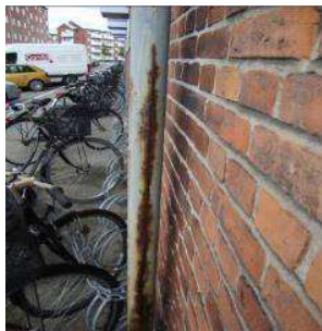
Enkelte tagnedløb (nederste 2 meter) er helt tæret. Disse er udført i støbejern, og de er i meget ringe stand. Bør skiftes.
