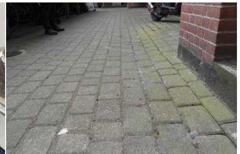
I 2016 ses mindre sætninger i belægning. Det formodes, at dette er almindelige sætninger (pga. ringe komprimering af jorden), da der ikke er tale om meget lokale sætninger.
