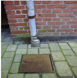
Overgang tagnedløb til sandfang (varierende udførelse).
