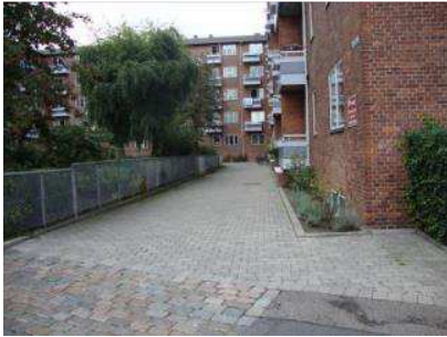
Belægninger ved Milanogården er ligeledes i god stand.
