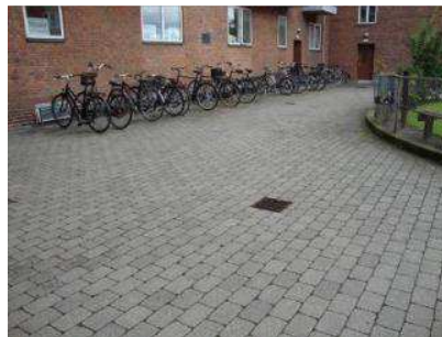
Belægninger er ligeledes i god stand ved Korsikagården mod Milanovej.
