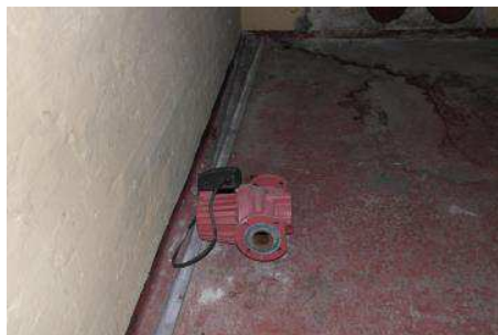
Cirkulationspumper udskiftes løbende. Gamle pumper bør fjernes.
