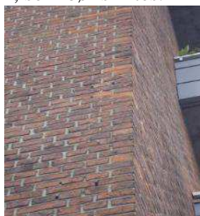
Hjørner på ejendommen er generelt udsatte, og her skal påregnes nogen eftergang af fuger samt udskiftning af mursten.
