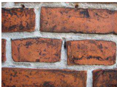
Dårlige studsfiger bør udbedres.
