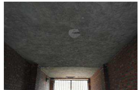
Det anbefales at opsætte troltex på loftet i portrummet ved Milanogården i stil med loftet i Korsikagården. Se også EMO-rapport.
