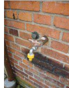
Her er ligeledes udvendig vandinstallation.
