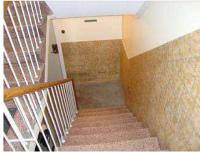
Der er ligeledes klinker på nederste del af væggene til kælderen. Er generelt i god stand.
