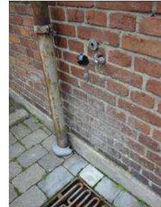
Udvendig vandhane med tilhørende kloakrist.
