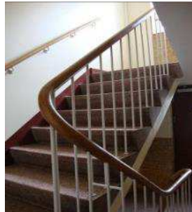
Håndlister er lakerede, og balustre er malet rundjern.
