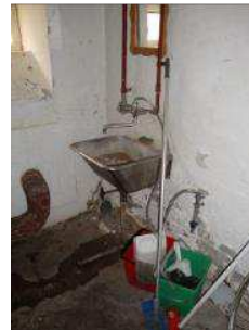
Ved fyrrum i Korsikagården er der udslagsvask.
