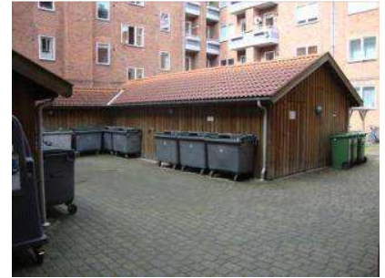
Containergård, ligeledes i baggården i Korsikagården.
