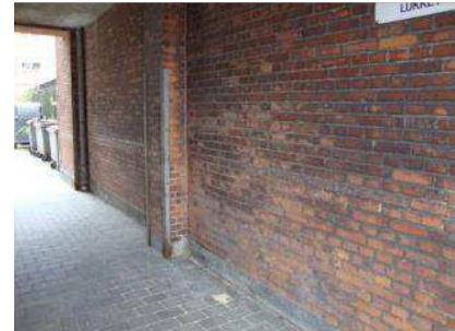
Murværk i porten er noget medtaget, ligesom hjørnejern forveden er tæret af salt.
