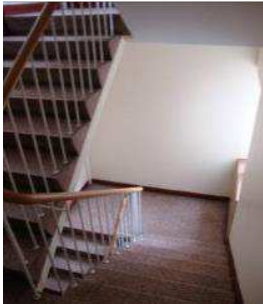
Trapper er generelt i ens, pæn stand. Støbte trappeløb med terrazzooverflade.
