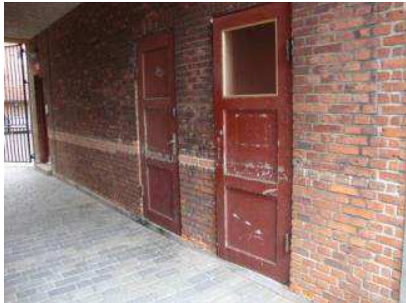
Tydelige aftegninger efter transport med container i porten på Korsikagården.
