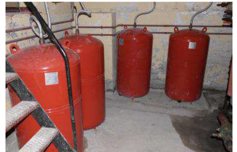
Her er mærkater med asbest. Der skal tages højde for asbest, når rør skal efterisoleres.
