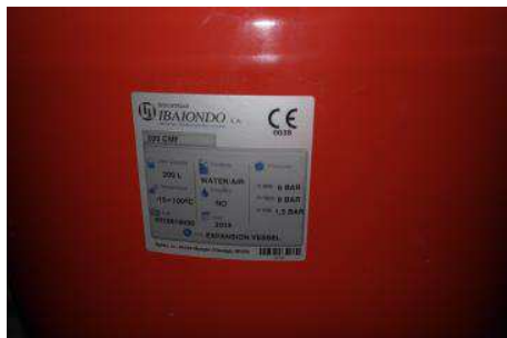
2 x 4 styk trykspansionsbeholdere er udskiftet i 2014.
