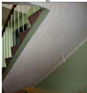
I opgange, hvor underside trappe løb ikke er istandsat, ses krakeleringer af maling. Billedet er fra 2011, og opgangen er istandsat efterfølgende.
