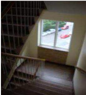
Vinduesplaceringen er forskellig i opgangene. Under vinduer er flisebeklædning i god stand.
