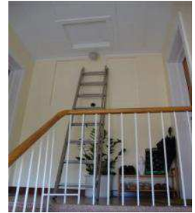
Adgang til loftsrums Venedigvej 13. Der må ikke opbevares indbo på fællestrapper af hensyn til brand og flugtvej.
