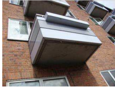
Altaner udført med betonbund.
