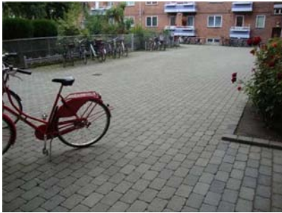
Belægninger ved Milanogården er ligeledes i pæn stand.
