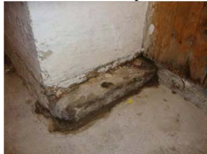
Opfugtet sokler i kælder (Flere steder).
