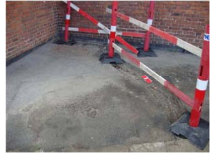
Der er en igangværende opgravning mod Strandlodsvej (2011).
