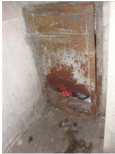
I forbindelse med nedfaldsskaktene er der gulv afløb.
