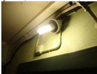
Belysning i kælderen anbefales udskiftet i henhold til EMO-rapport.
