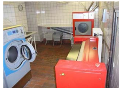
Her er 4 vaskekældre i ejendommen. De er generelt i pæn stand. Her er klinker på vægge og gulve.
