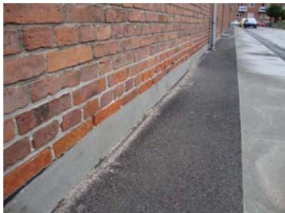
Nederste skifter er generelt meget ødelagt grundet høj saltpåvirkning. Se også afsnit 2.
