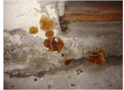
Svampeangreb på både træværk og murværk. Her ses svampe i kælderen Korsikagården.
