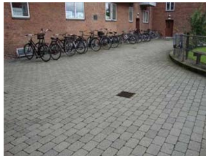
Belægninger er ligeledes i god stand ved Korsikagården mod Milanovej.
