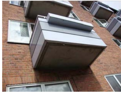
Altaner udført med betonbund.
