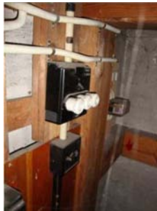
Gamle sikringsgrupper, som ikke er i brug, bør fjernes.
