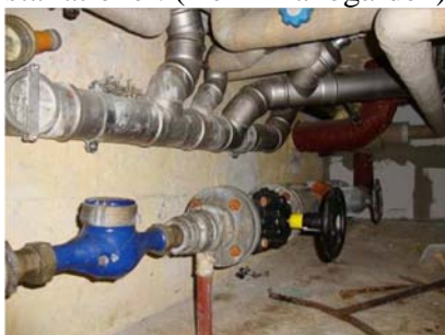
Eksempel på vandmåler i kælder.
