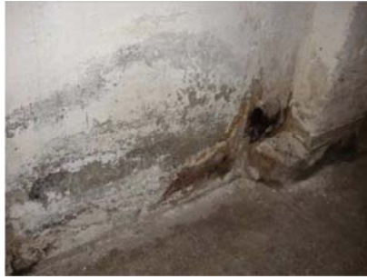
Opfugtet murværk.
