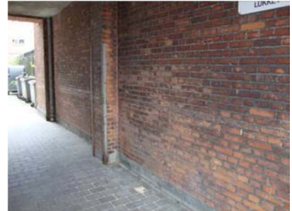
Murværk i porten er noget medtaget, ligesom hjørnejern forinden er tæret af salt.
