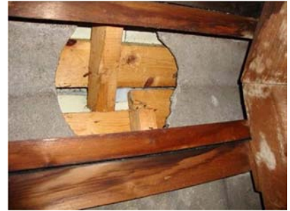
Ødelagt eternittag (fra monteringen af Decra). Ingen praktisk betydning nu.
