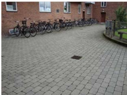
Ligeledes pæn belægning med kloakrist. (Korsikagården)
